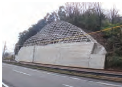
防災対策の一例(のり面防護工)
