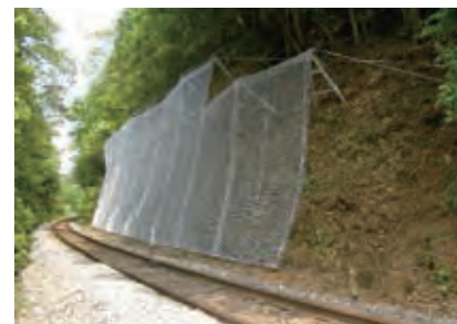
防災対策の一例(落石防止網)
