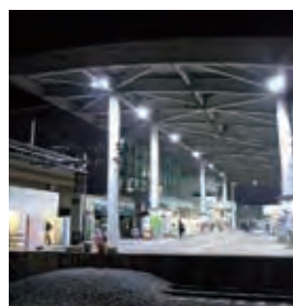
ホーム天井照明のLED化(高松駅)
