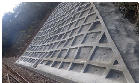
のり面防護工
