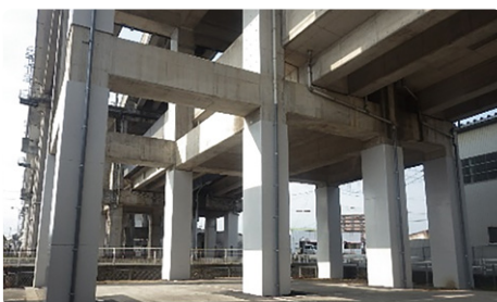
高架橋の柱に対する耐震補強①
