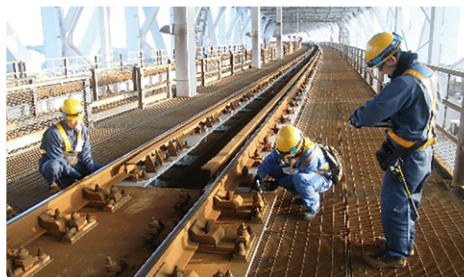
瀬戸大橋における定期検査
