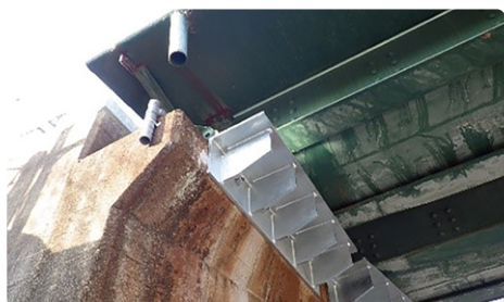
架道橋における落橋防止対策
