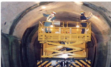
トンネルにおける保守用車を用いた検査
