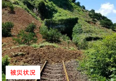
②下宇和・立間間283k990m 斜面崩壊
